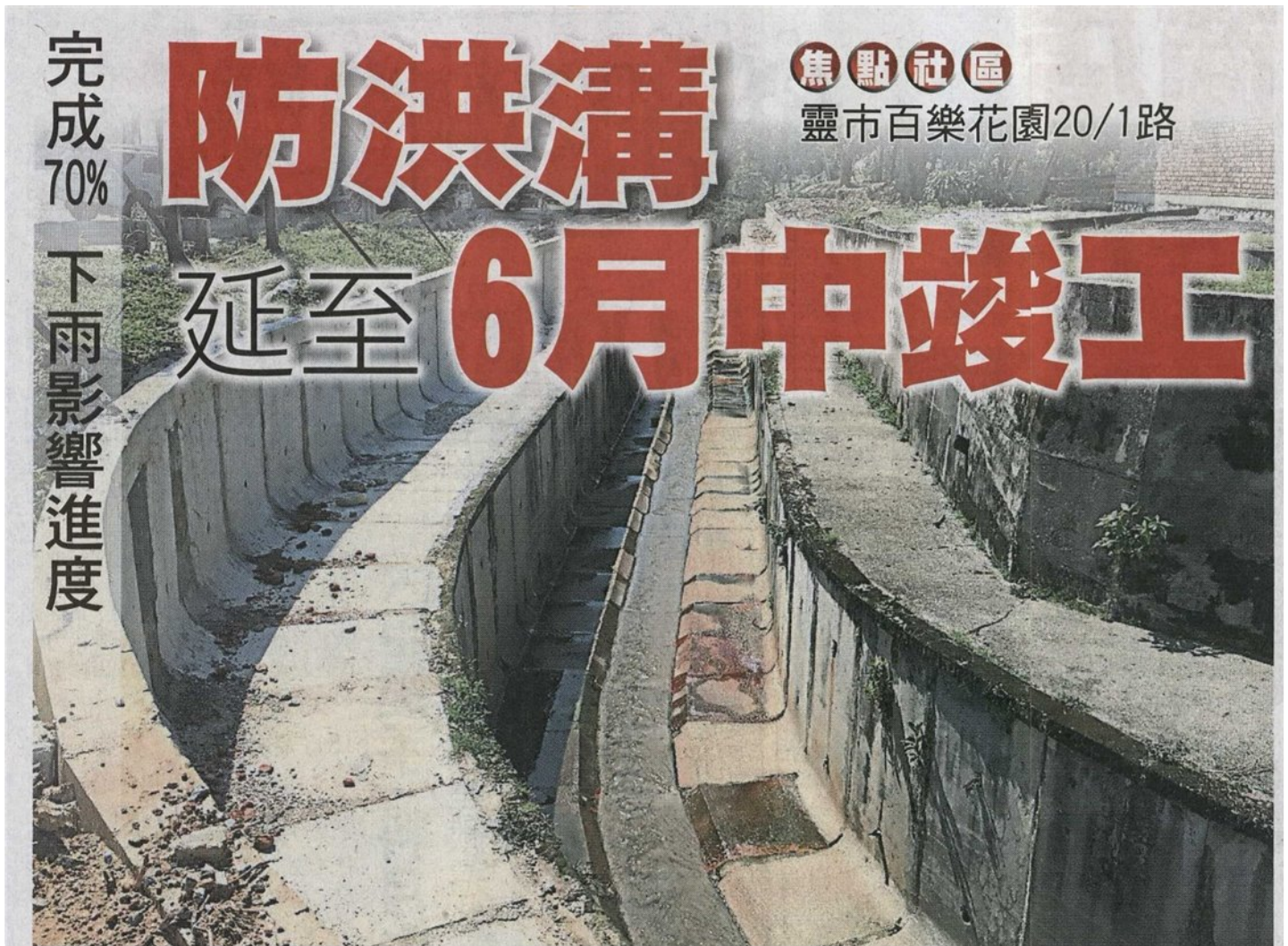
▲八打灵再也市政厅未雨绸缪，耗资约104万6千令吉提升灵市百乐花园20/1路旁的防洪沟，以防闪电水灾的发生。
